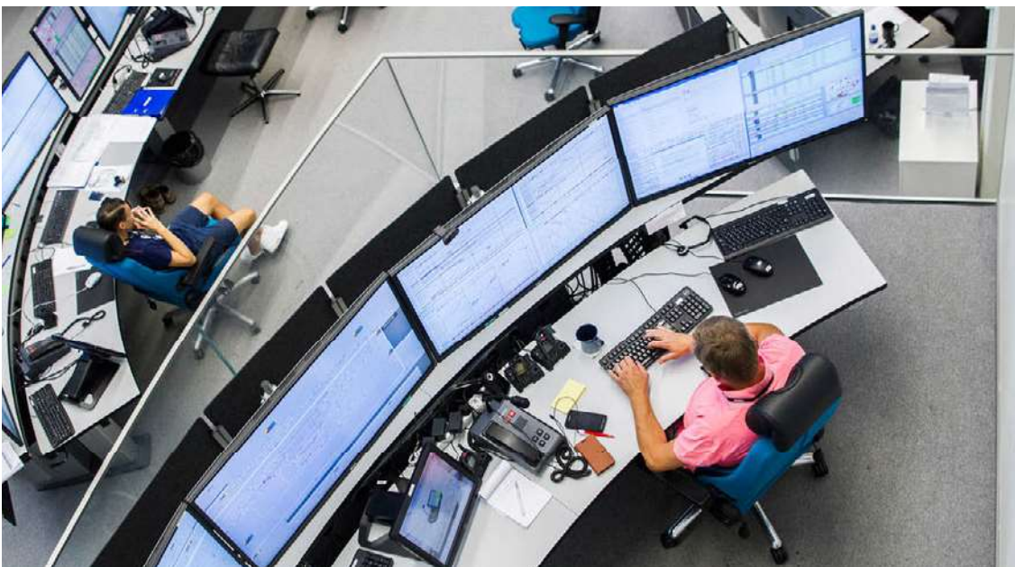
Bild 1: Verkehrsleitzentrale Fig. 1: A traffic management centre
