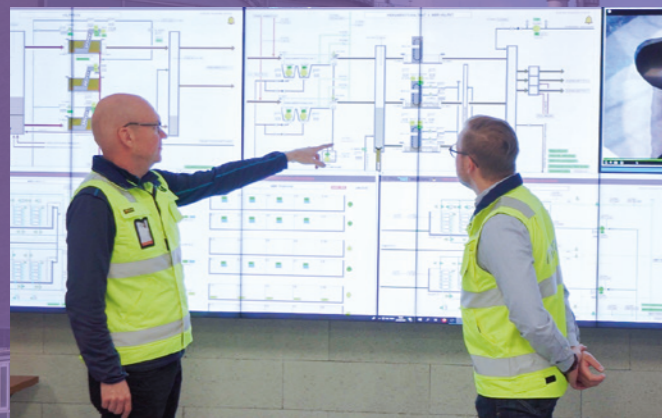
Mikkelin Metsä-Sairilan jätevedenpuhdistamon valvomo peruskallion sisällä.
